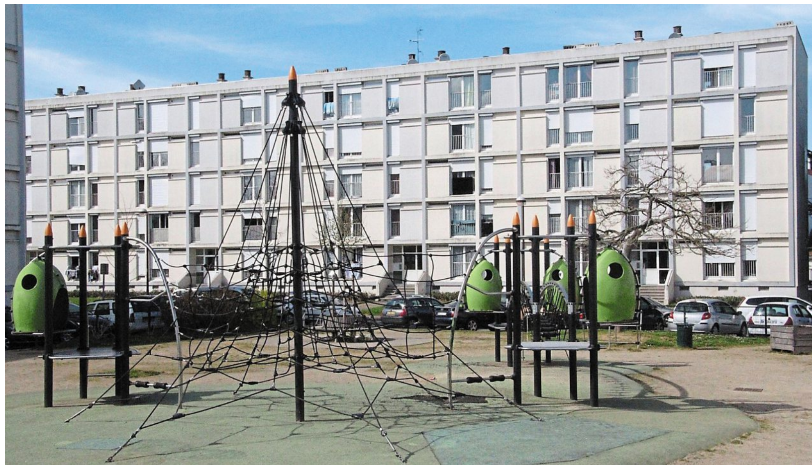
La barre « Pontchâteau », la première qui sera rénovée en 2018.
